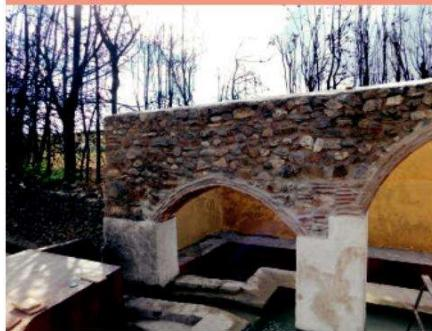
El Ayuntamiento de Gata ha llevado a cabo trabajos de mejora de los arcos del paraje de La Rana. Las obras han consistido en la reparación, consolidación y refuerzo de los arcos que estaban deteriorados y con desprendimientos.
